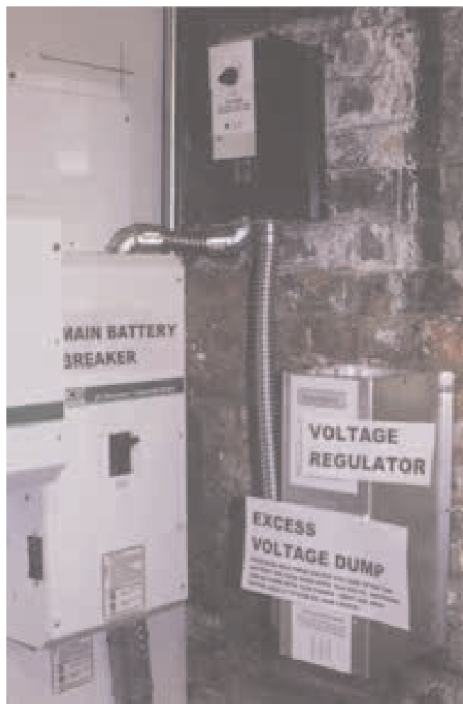
Enermaxer dump load.
