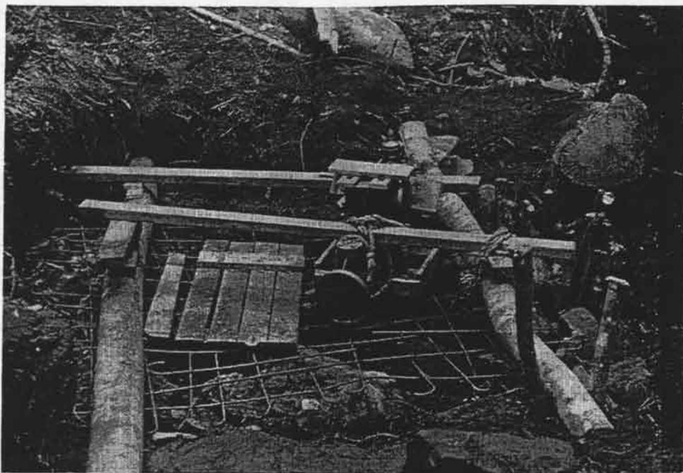
9 - 10 - 11 - 12. Une fois le béliet mis en place, on peut commencer à poser la conduite d'écoulement qui amène l'eau jusqu'à la mission, distante de 1 km, à une hauteur de 75 m. Nous aurions pu nous servir de tuyaux en P.V.C. Nous avons préféré du galvanisé, plus solide et durable.
