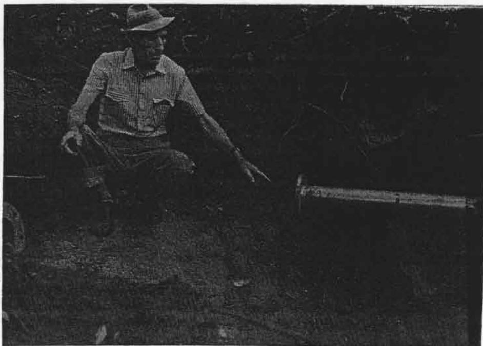
Sur l'extrémité de la conduite d'amenée, nous avons boulonné une vanne ; ce qui nous permet de vider le bassin 2 pour nettoyage sans vider à la fois toute la conduite d'amenée.
