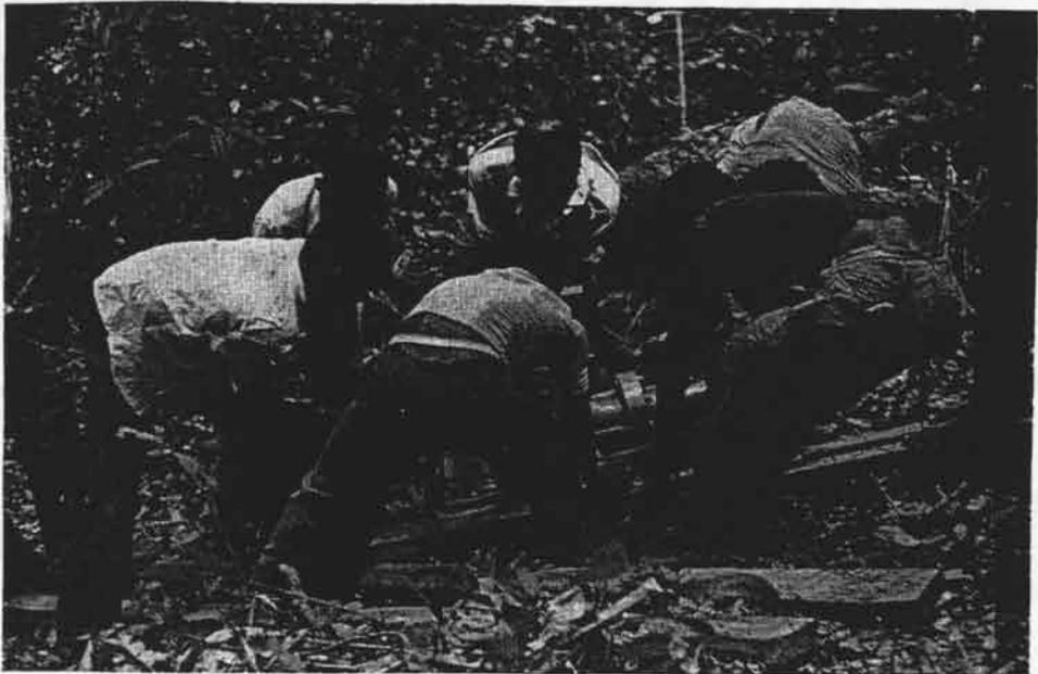
8. Pour ancrer le béliet solidement et correctement sur son socle on l'a suspendu avant de couler le béton.
